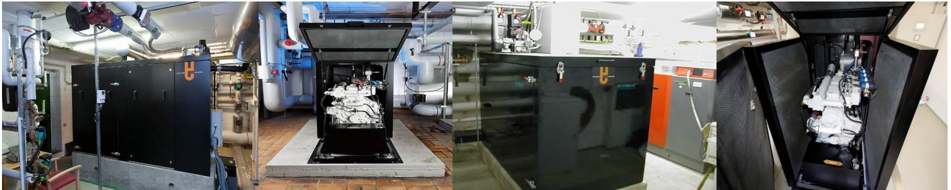
CHP Vivantes 48 kW el / 97 kW th
