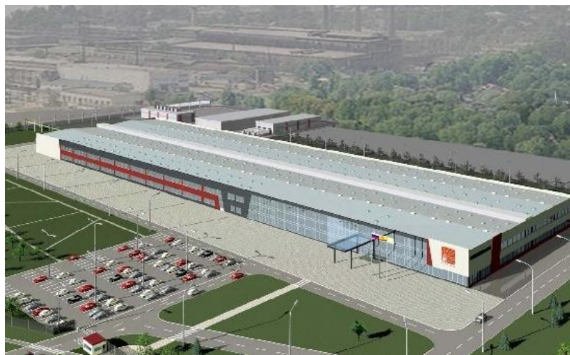
Общий вид производственного комплекса «Хевел»
