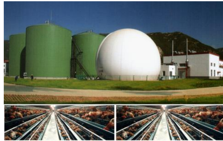
北京德青源鸡场日处理鸡粪212吨，产沼气1.9万m 3 ，发电能力1.6MW，年减排CO 2 8万吨。
