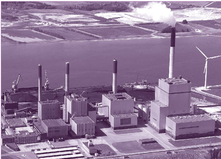
Figure 4 • Nordjyllandsværket general view
